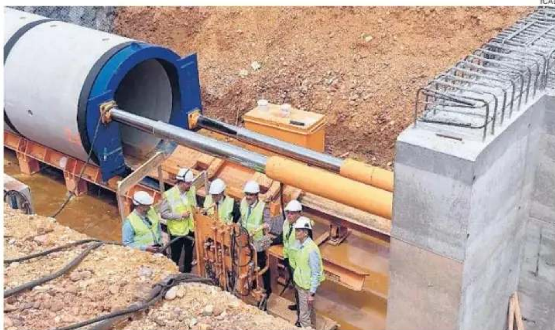
Trabajos de urbanización en el polígono industrial de Villadangos del Páramo
